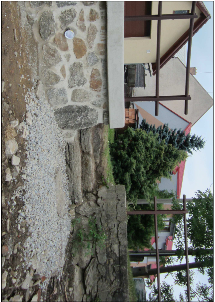
SCHODIŠTE K PŘESKLADÁNÍ DO BETONU A PŘESPAŘOVÁNÍ
