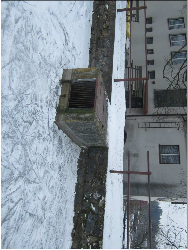
VÝSTUPNÍ OBJEKT – BEZ ÚPRAV, ZACHOVAT DILATAČI
