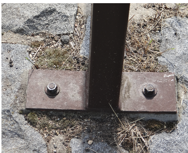
Obr. č. 9: Detail uchycení sloupku na koruně nábrežní zdi.
