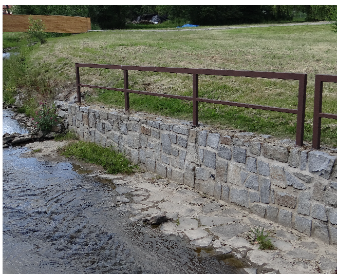
Obr. 11: Nejhornější díl zábradlí č.4 tvoří 3 pole, ostatní díly tvoří jen 2 pole.
