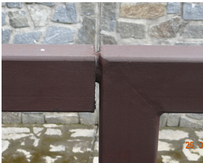
Obr. č. 7: Detail nasunutého horního madla na přivařeném trnu na předchozím sloupku
