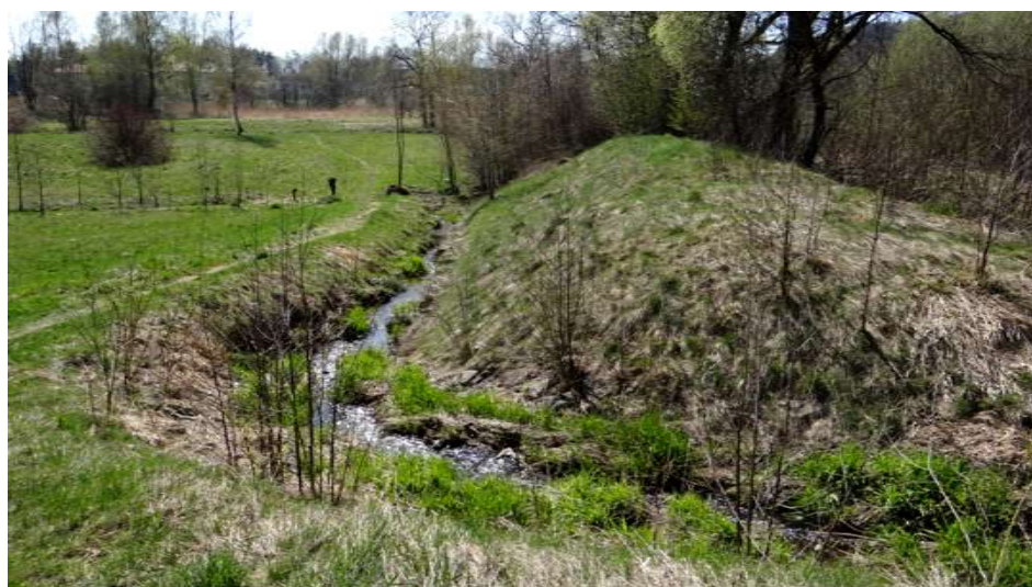
Obr. 2: Současný překop hráze a odtokové koryto pod hrází
