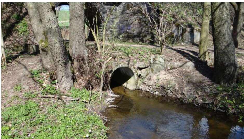
Obr. č. 12: Vyústění zatrubněného Cihelského potoka pod drážním mostem
