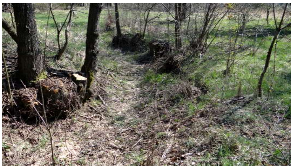
Obr. č. 5: Současný bezpečnostní přeliv – pouhá drobná vodoteč bez zpevnění
