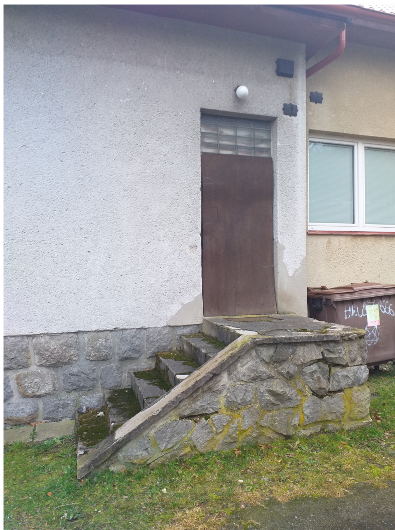
Obr. 2 – plošina se schody a vstup do sklepa (odstranění a zapravení)
