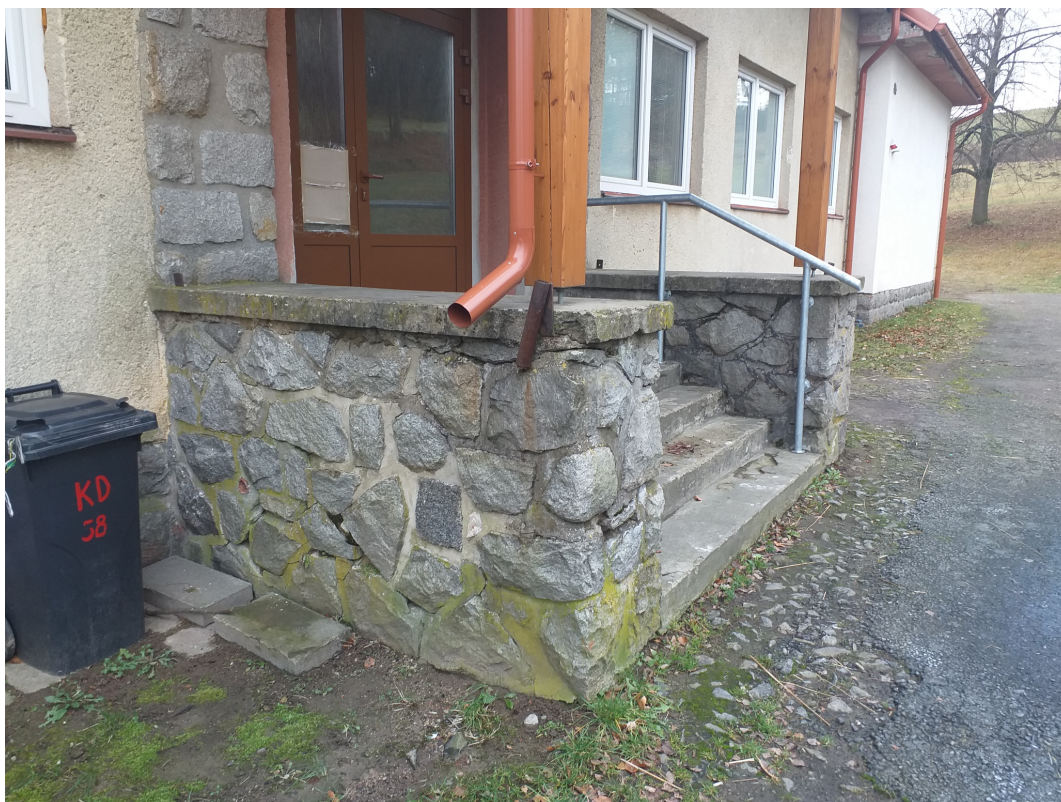
Obr. 3 – hlavní vstup do objektu (oprava kamenných zídkek)
