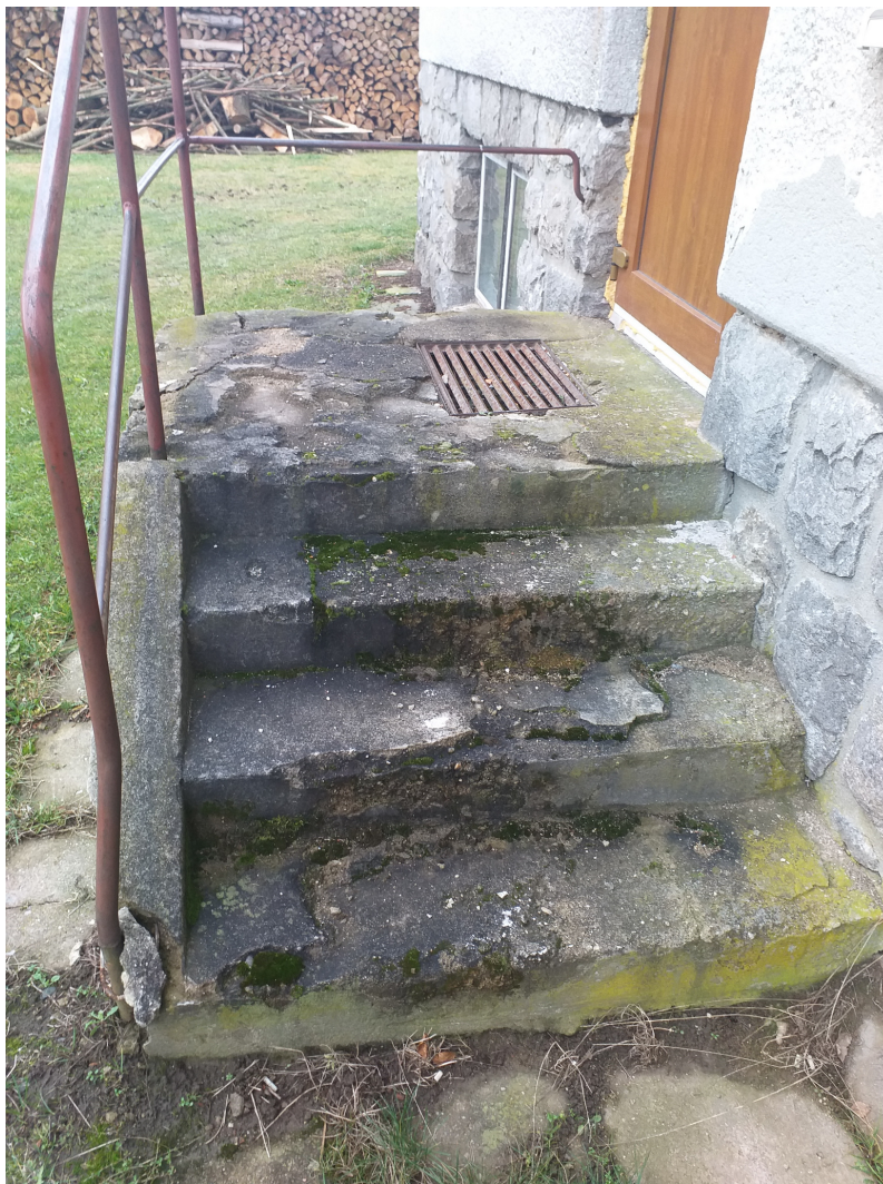
Obr. 7 – schody u vstupu z východní strany (oprava)
