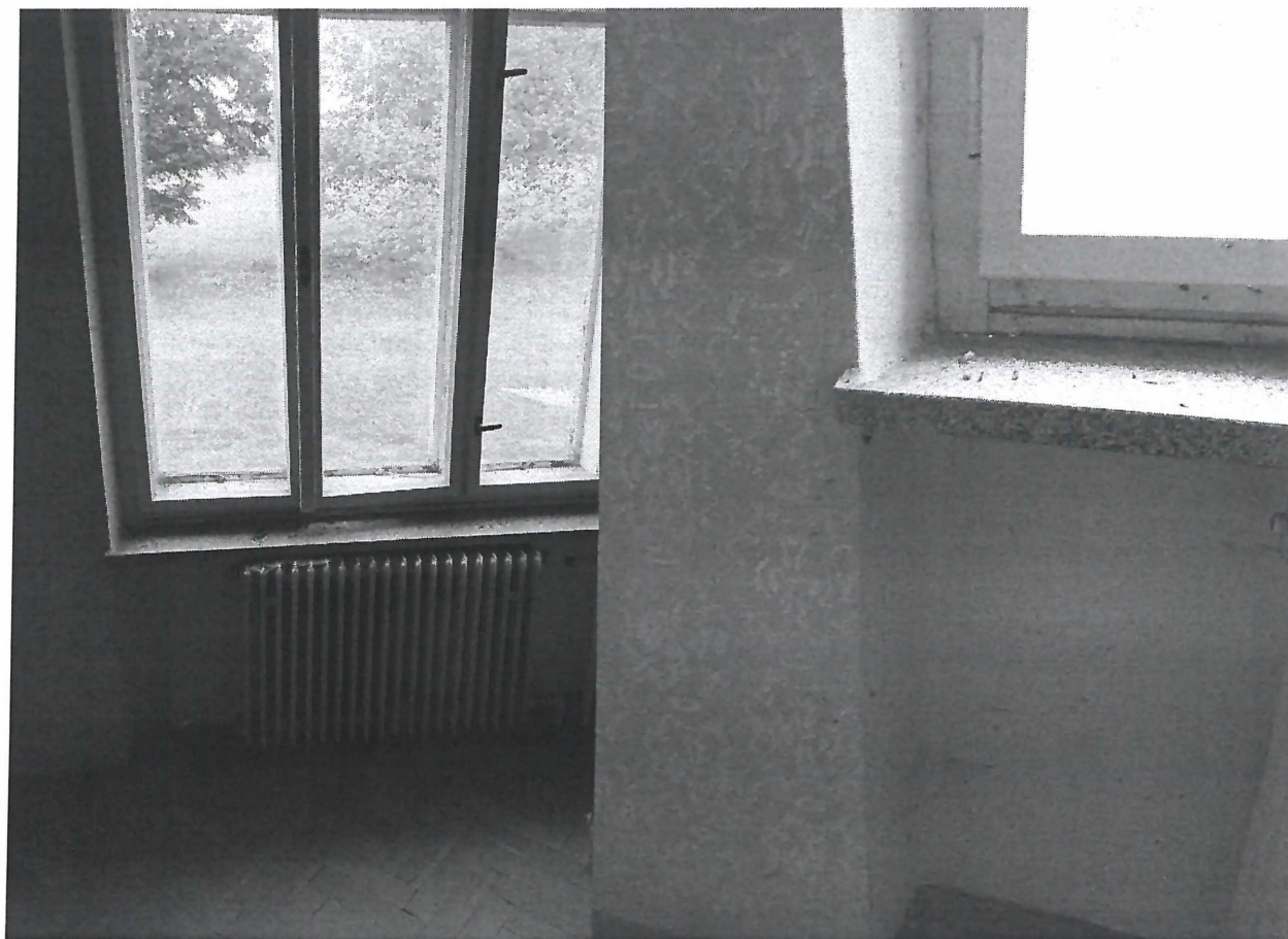
Stávající osazení parapetu
