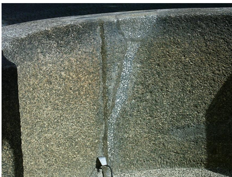
nádoba kašny – detaily spár stěn kašny
