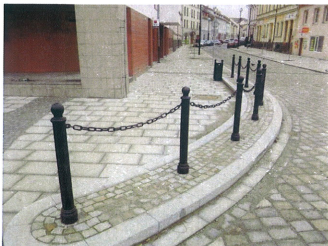
Zahrazovací sloupek litinový, osmiboký
