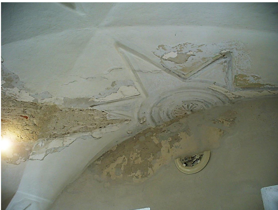
ŠTUKOVÁ VÝZDOBA – POHLED NA ODHALENÉ PORUCHY OMÍTEK V SOUVISLOSTI S LOKÁLNÍ OPRAVOU
