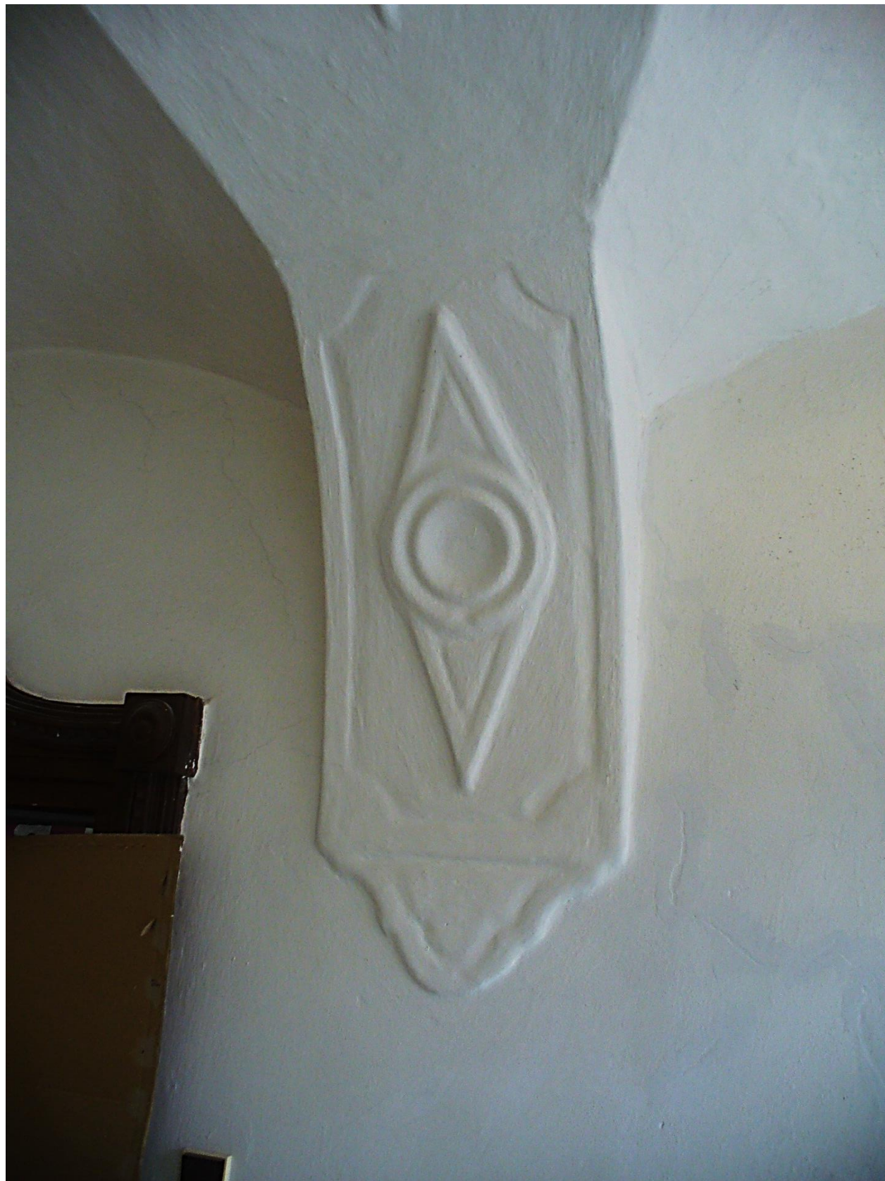
ŠTUKOVÁ VÝZDOBA – POHLED NA KONZOLU S RÁMOVÁNÍM, DEKOREM A ČABRAKOU
