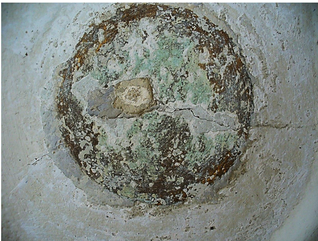
ŠTUKOVÁ VÝZDOBA – POHLED NA TERČ KONZOLY S ODHALENÝMI DRUHOTNÝMI BAREVNÝMI VRSTVAMI
