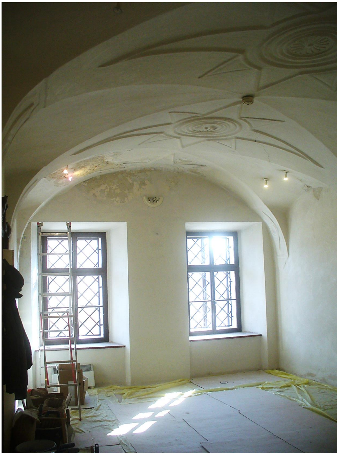
ŠTUKOVÁ VÝZDOBA – POHLED NA KLENBU A OKENNÍ OTVORY
