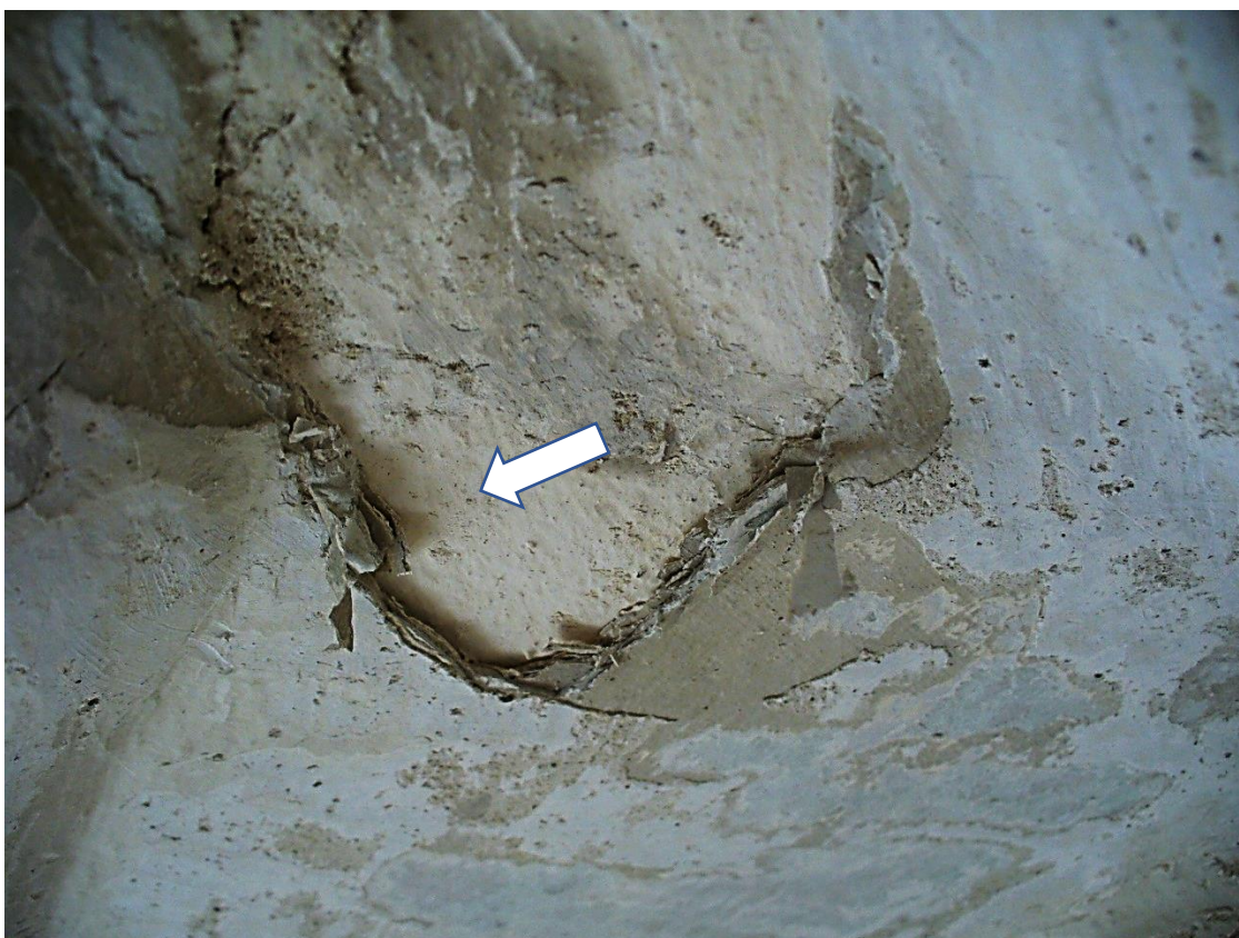
ŠTUKOVÁ VÝZDOBA –STROP, SONDY DO VRSTEV NÁTĚRŮ, ŠIPKA UKAZUJE NEJSTARŠÍ OMÍTKOVÉ VRSTVY
