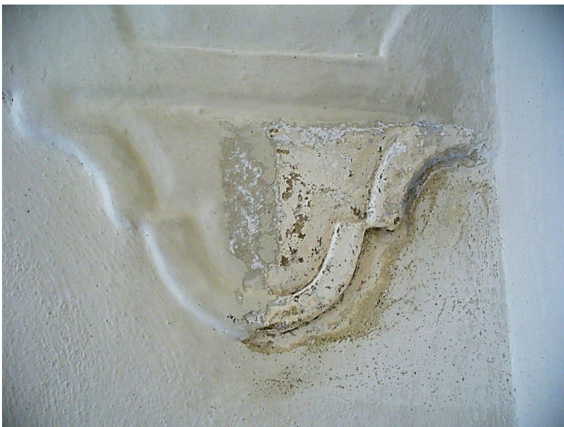
ŠTUKOVÁ VÝZDOBA – POHLED NA ČABRAKU KONZOLY PO ČÁSTEČNÉM SEJMUTÍ NEPŮVODNÍCH VRSTEV
