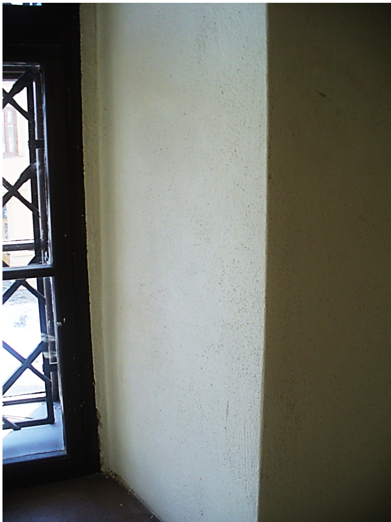
ŠTUKOVÁ VÝZDOBA –SVISLÁ STĚNA, DETAIL NOVĚ OMÍTNUTÉ PLOCHY ŠPALETY OKNA – POVRCH UPRAVENÝ FILCOVÝM HLADÍTKEM
