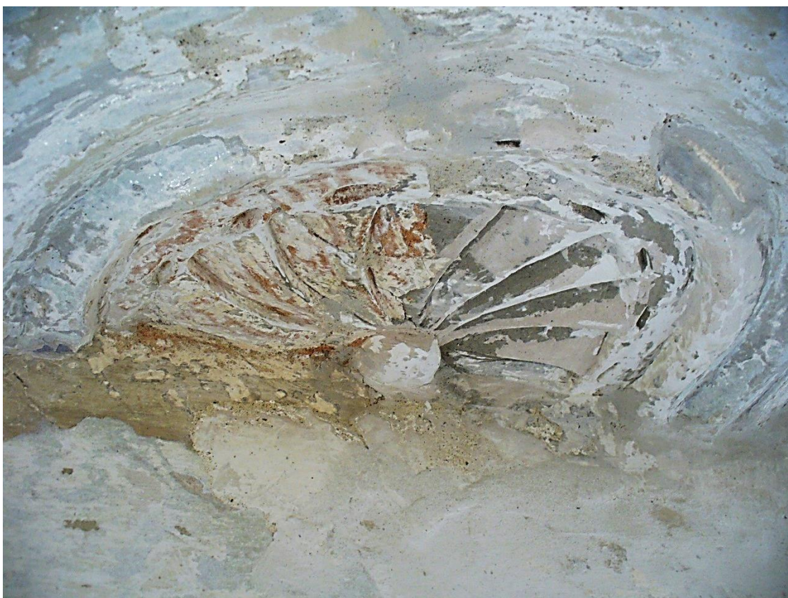
ŠTUKOVÁ VÝZDOBA –STROP, SONDY DO VRSTEV NÁTĚRŮ, DETAIL PRVKU ROZETY
