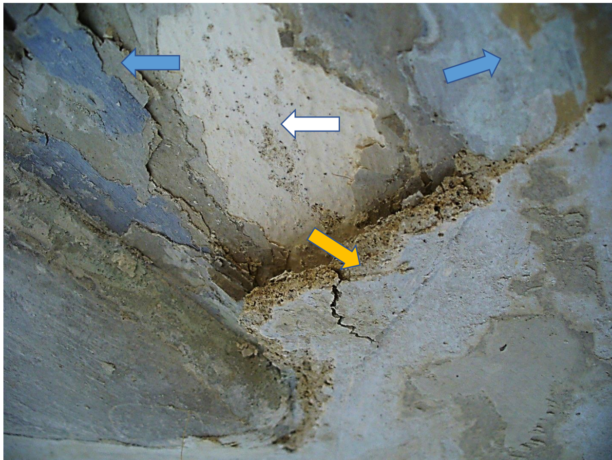
ŠTUKOVÁ VÝZDOBA –STROP, SONDY DO VRSTEV NÁTĚRŮ A DRUHOTNÝCH OPRAV OMÍTEK
