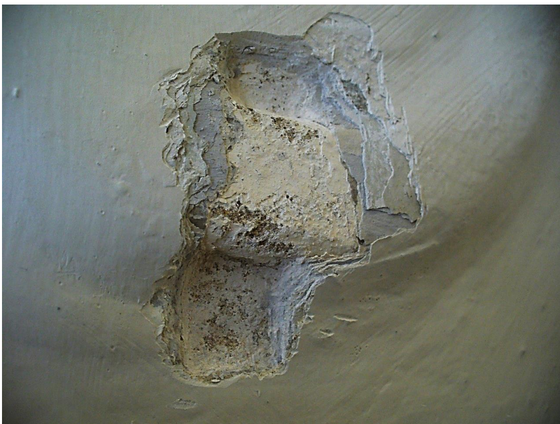
ŠTUKOVÁ VÝZDOBA – POHLED NA PRVEK, ZASLEPENÝ NÁTĚRY, ODHALENÍ PŮVODNÍ PROFILACE PRVKU
