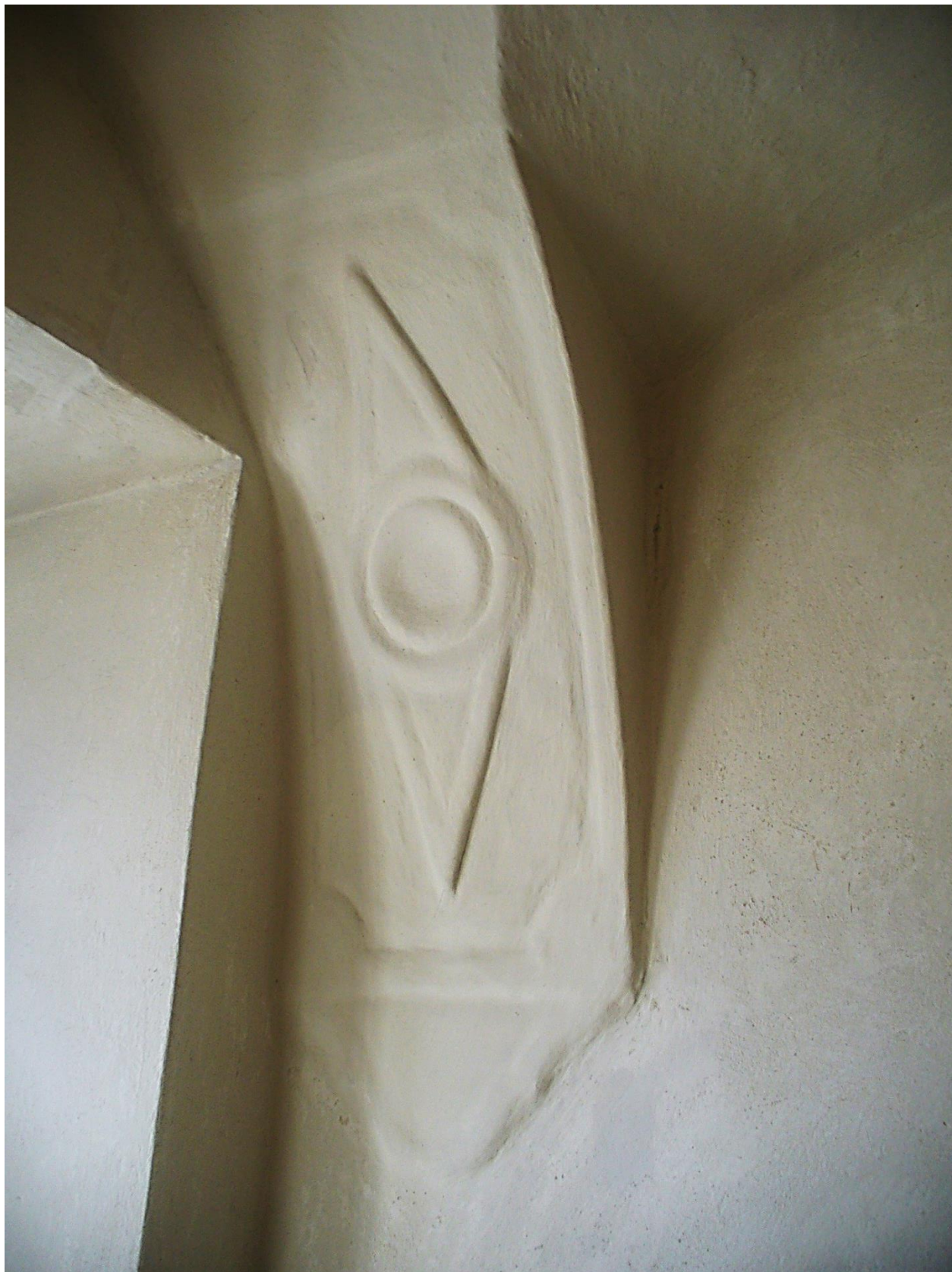
ŠTUKOVÁ VÝZDOBA – POHLED NA KONZOLU S RÁMOVÁNÍM, DEKOREM A ČABRAKOU (KRAJNÍ KONZOLA U OKNA)
