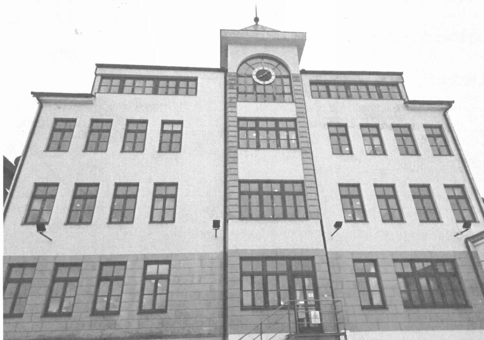
Obr. 1 – severozápadní strana objektu (výměna v 1. a 2. NP)
