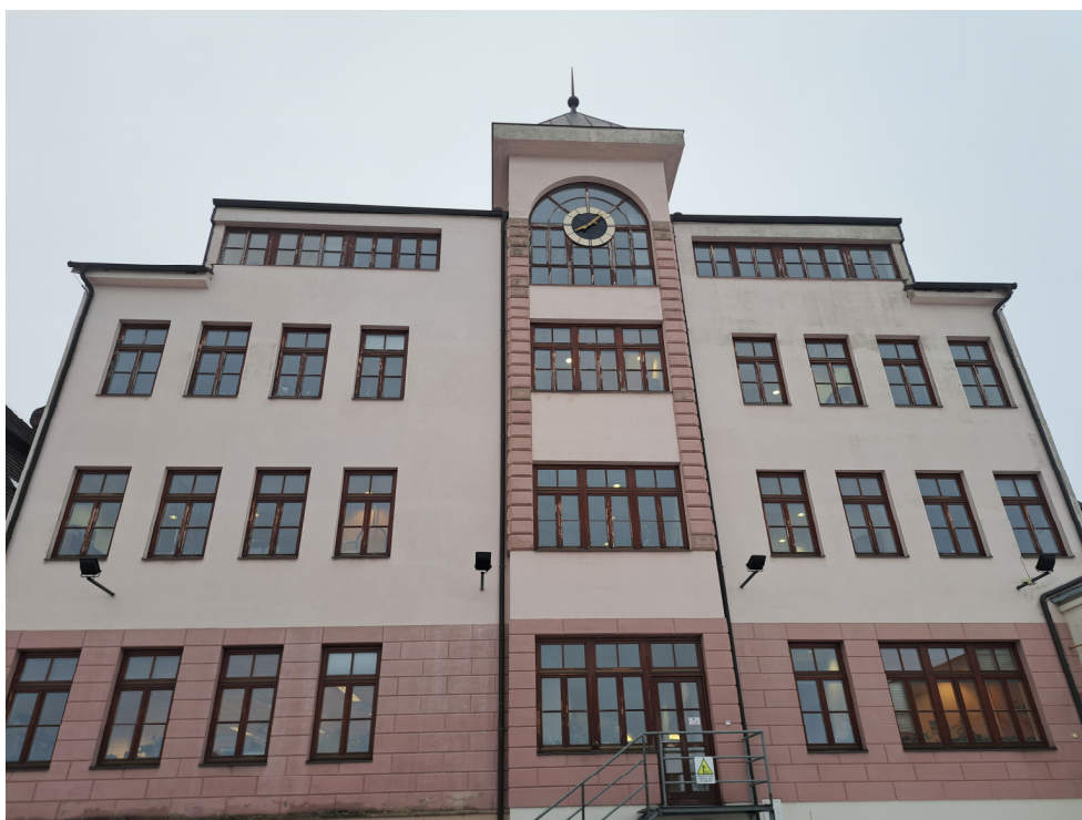
Obr. 1 – severozápadní strana objektu (výměna v 1. a 2. NP)
