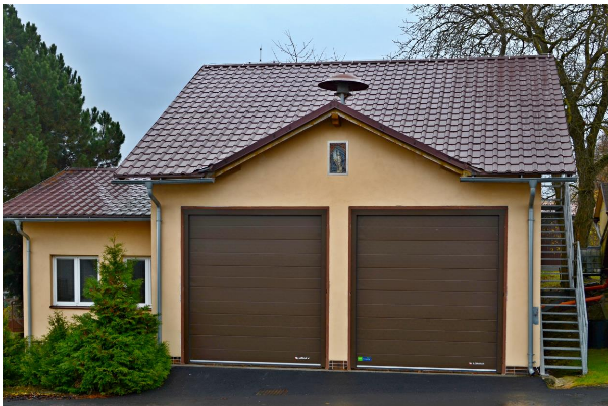
Obrázek 43: Sklad, garáže SDH, Hlinné 54
