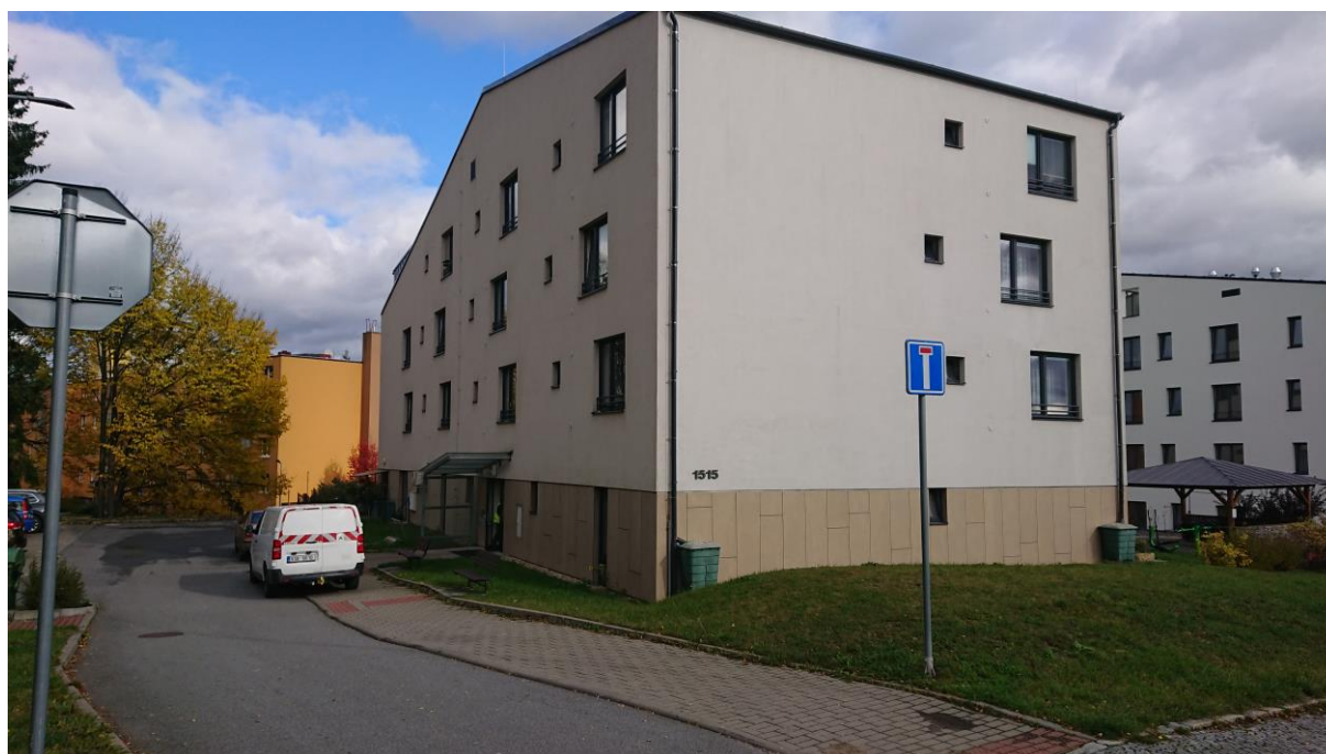
Obrázek 28: Obytná budova, Žďárská 1515
