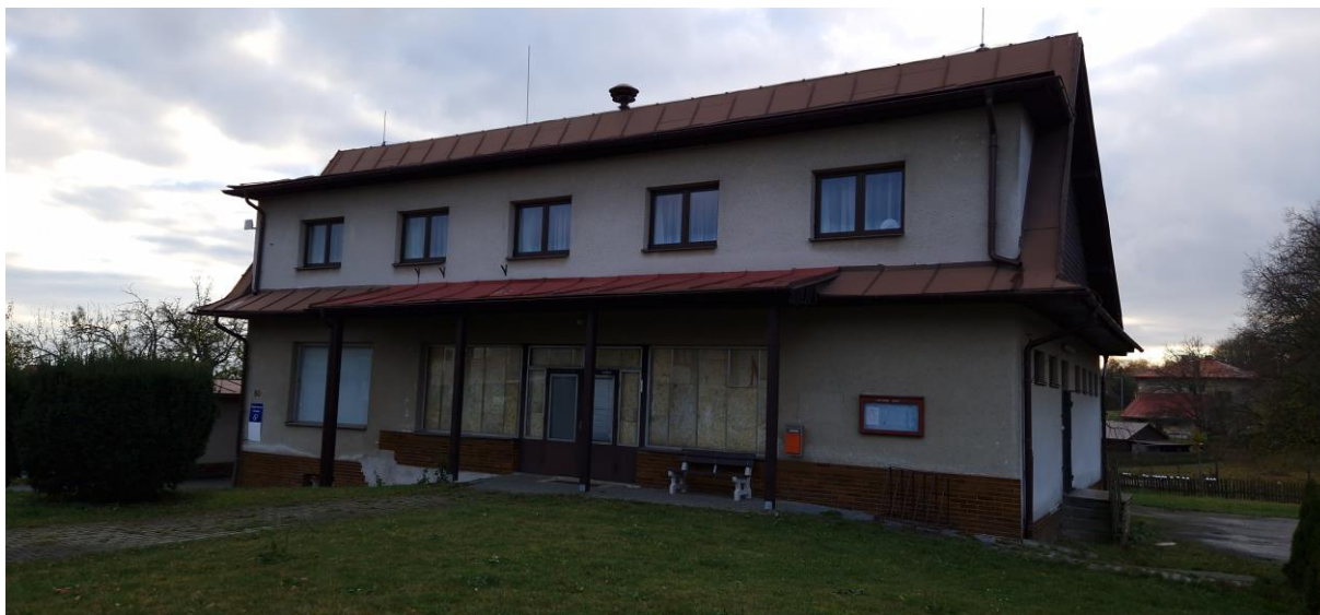
Obrázek 48: Nevyužívaná budova, Maršovice 80
