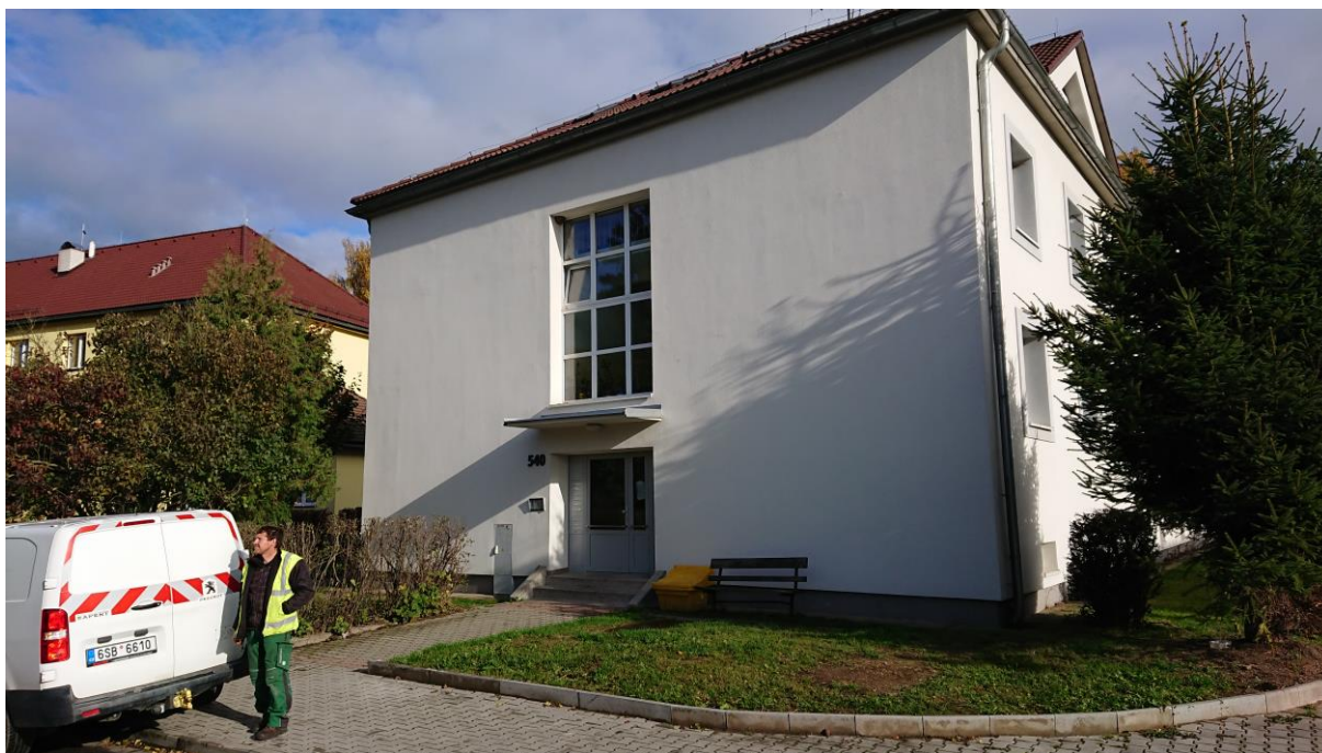
Obrázek 27: Obytná budova, Drobného 540
