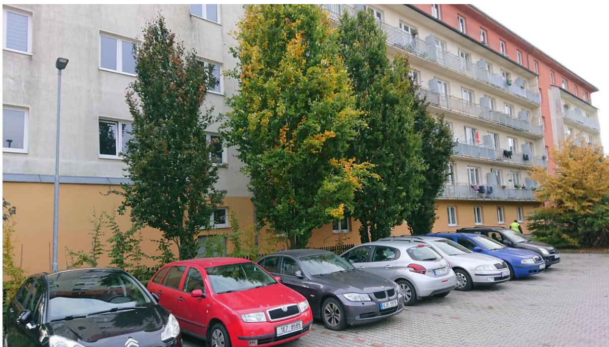
Obrázek 26: Obytná budova, Drobného 301
