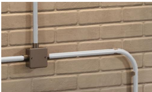
Obr. 1: Povrchové vedení v trubkách
