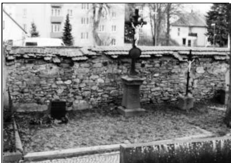
Obr. 4. Hrobová místa č. 179 - 182. Sokl bez kříže bude odstraněn, kříže budou restaurovány a ponechány na původních místech, stejně tak jako litá čísla hrobových míst na zdi. Prostor bude doplněn litinovými kříži na soklu a litinovými kříži bez soklů, které budou připevněny na zeď.
