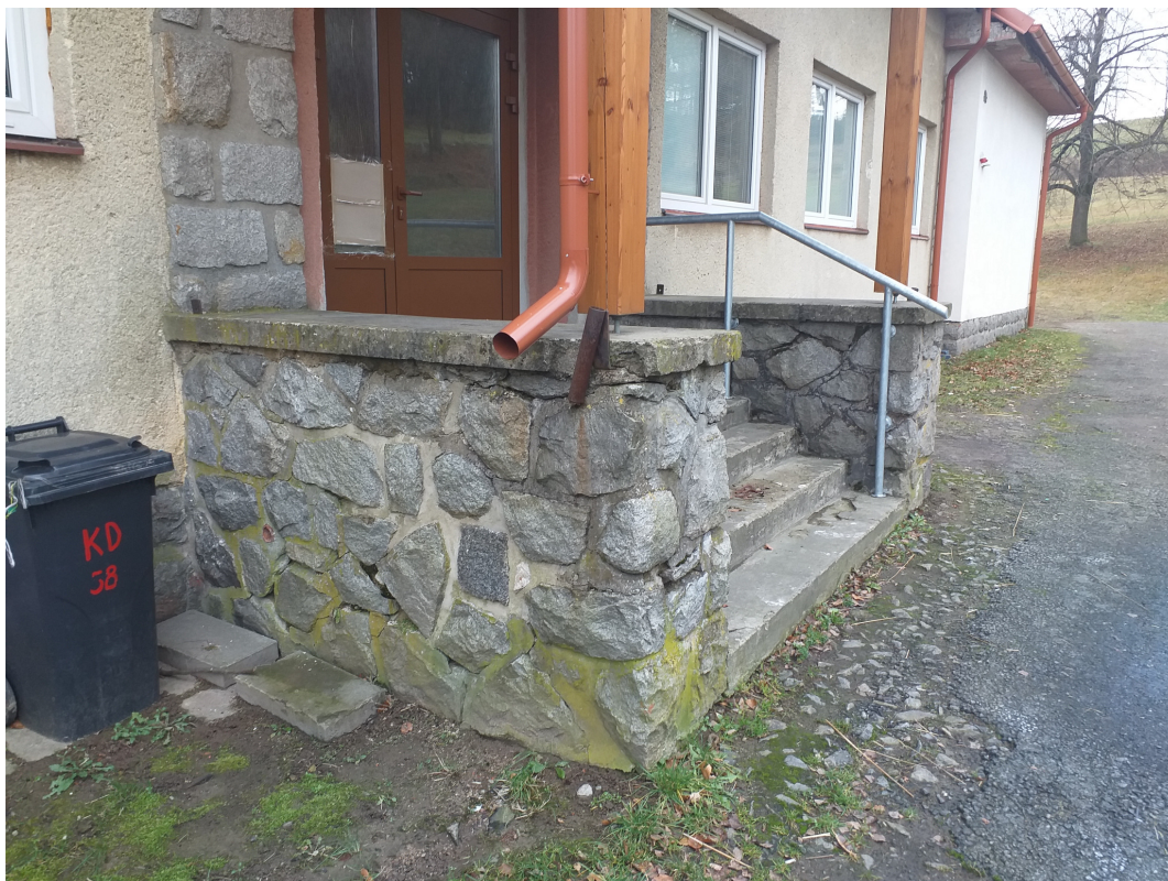
Obr. 3 – hlavní vstup do objektu (odstranění a výstavba nového schodiště)
