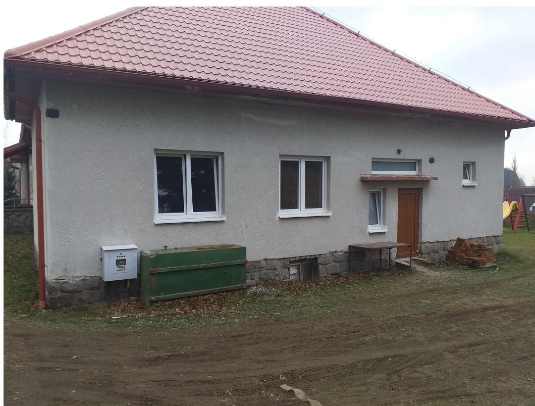
Obr. 4 – pohled západní (vybudování vstupní podesty u vstupu)
