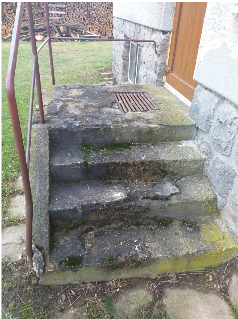
Obr. 7 – schody u vstupu z východní strany (odstranění a výstavba nového schodiště)
