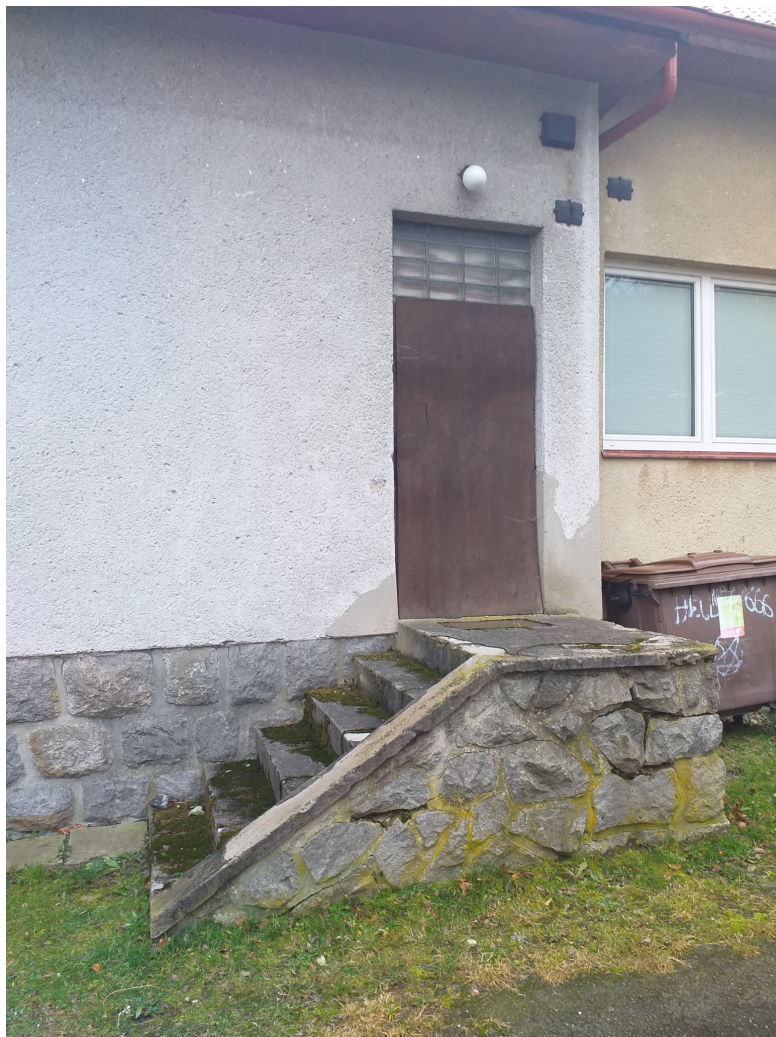
Obr. 2 – plošina se schody a vstup do sklepa (odstranění schodiště, osazení nových dveří v úrovni terénu, dozdění zbylého otvoru nad novými dveřmi, realizace plošiny pro přístup do sklepa)
