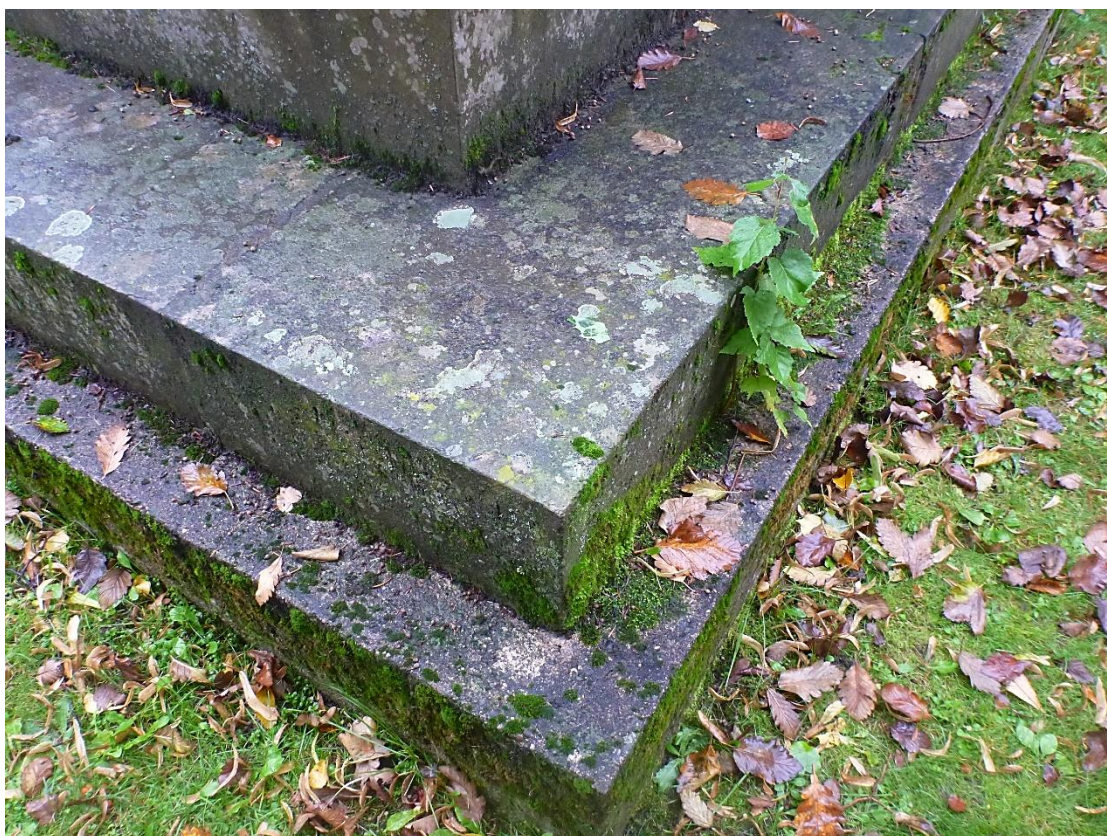
Pomník padlým vojínům – Pohřeb v Karpatech Současný stav, detail podstavce a základny, biologické znečištění
