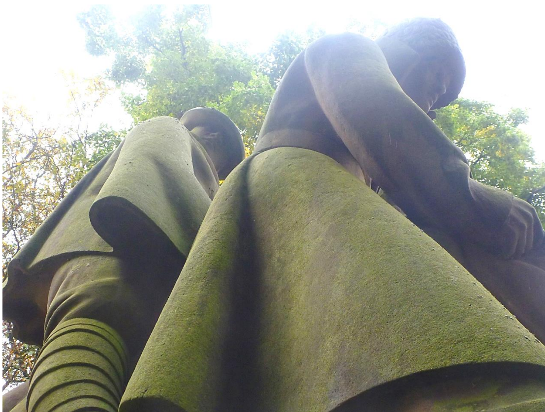
Pomník padlým vojínům – Pohřeb v Karpatech Současný stav, detail sousoší, biologické znečištění
