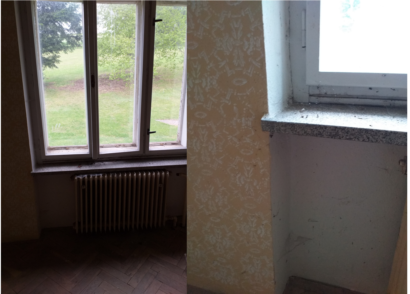
Stávající osazení parapetu
