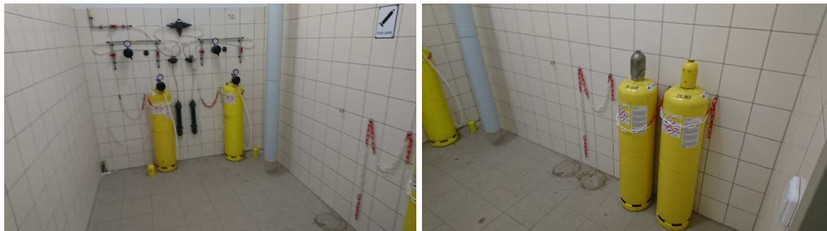
Obrázek 5: Vnitřní prostor chlórovny
