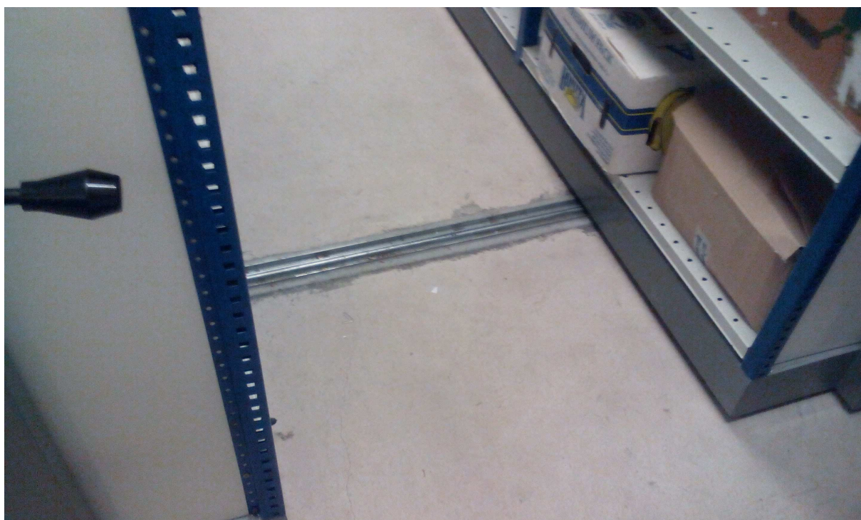
Obr.20 - vodící kolejnice pojízdných regálů
