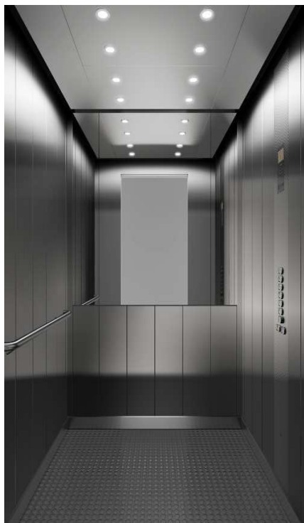
obr.č.1 – pohled do kabiny
