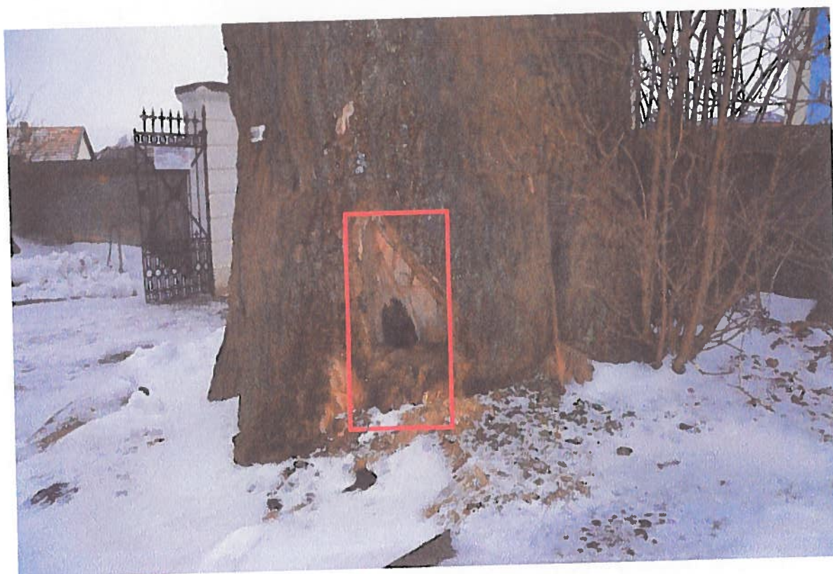
Obrázek 3 Detail báze kmene se sondou, jež byla zhotovena za účelem odvětrávání kmenové dutiny.
